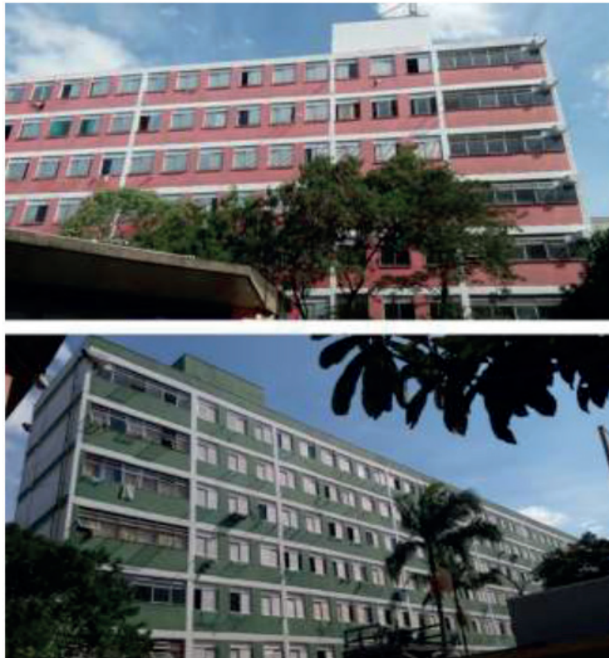
Fig. 1 - Fachadas dos bloco D e E
