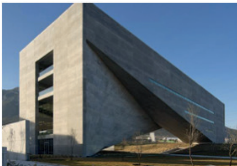
FIGURA 13: Centro Roberto Garza Sada, de Arte, Arquitetura e Design, Monterrey, México, 2013. FONTE: SOUTO, 2013.
